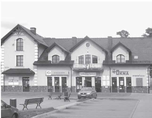
Budynek po remoncie (2010).
